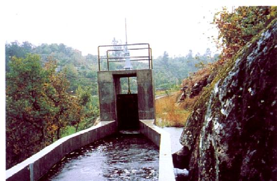
O circuito hidráulico desenvolve-se ao longo das margens direita do rio Covas e esquerda do rio Couto. No seu trecho em superfície livre, entre os açudes e a câmara de carga, é constituído por dois canais em betão armado, com 3200 m de comprimento global, com secção rectangular e larguras de 0,85 e 2,80 m.
