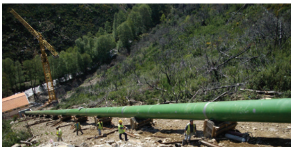
Conduta forçada e edifício da central. Fase de construção
