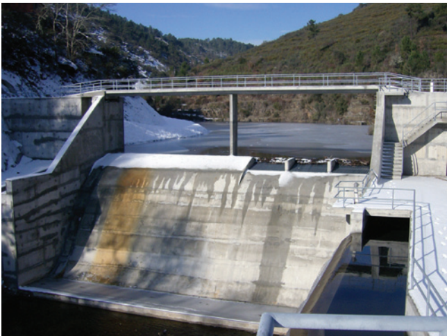
Açude do rio Tinhela e vista sobre o descarregador lateral
