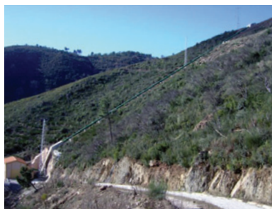
Conduta forçada e edifício da central
