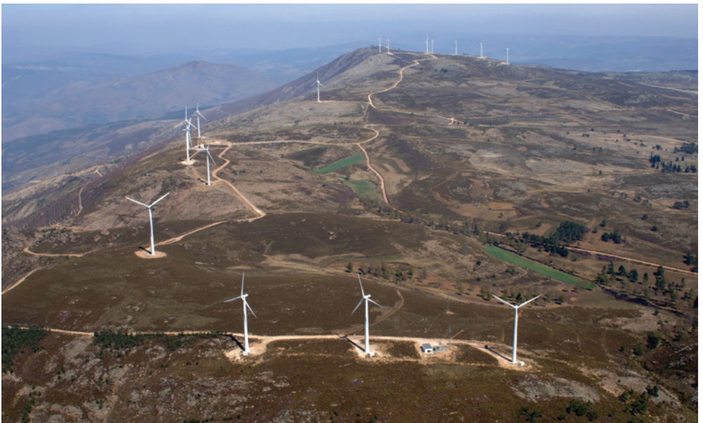
Parque Eólico da Bulgueira
