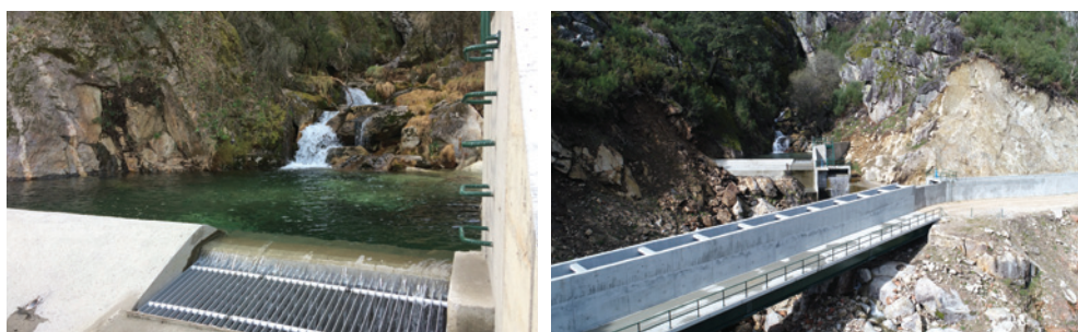
Açude na ribeira de Rebordondo. À esquerda, zona da tomada de água e, à direita, vista da ponte canal.
