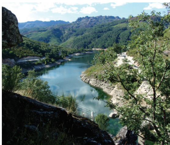
Vista da albufeira de Salamonde e do ramal de interligação do aproveitamento à rede elétrica nacional.
