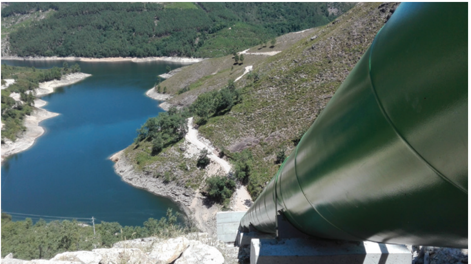
Vista do trecho inicial da conduta forçada sobre a albufeira de Salamonde.
