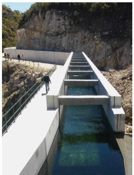
Ponte canal, descarregador lateral de jusante e plataforma adjacente de circulação.
