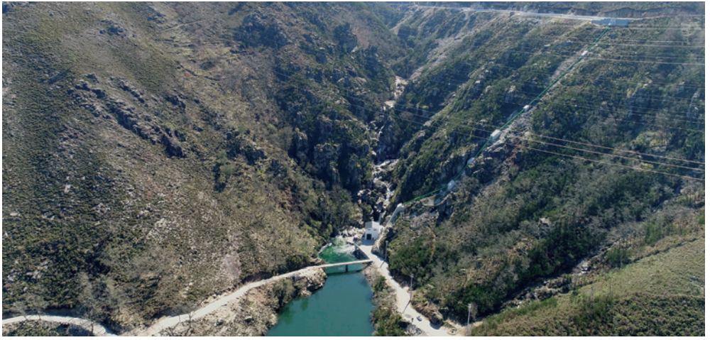
Central hidroelétrica. Vista aérea do trecho final do canal, da câmara de carga, da conduta forçada e da central.
