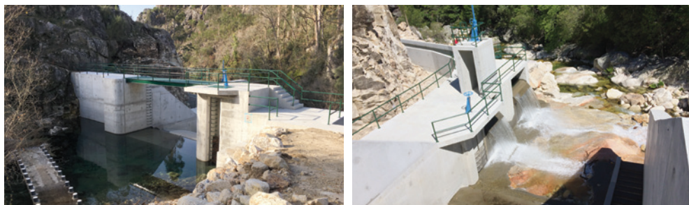
Açude no ribeiro de Chedos. À esquerda, vista de montante e, à direita, descarregadores laterais e parte terminal da rampa para toupeiras.
